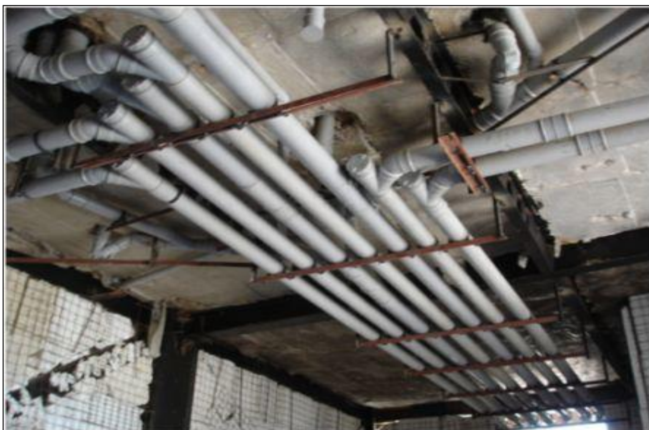
نصب لوله بصورت افقی
